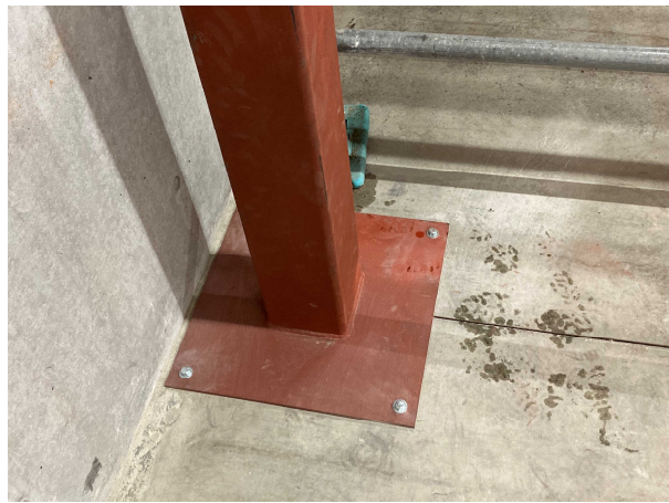
写真 1.3.4 支柱脚部の設置
