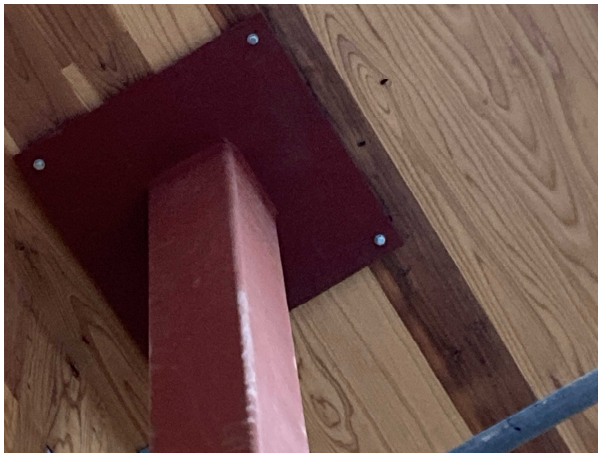
写真 1.3.3 支柱頭部の設置
