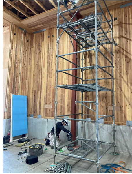
写真 1.3.2 足場・支柱の設置
