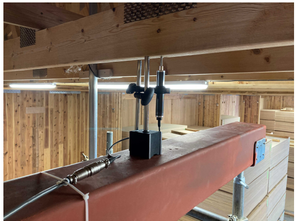
写真 1.3.4 変位計の設置
