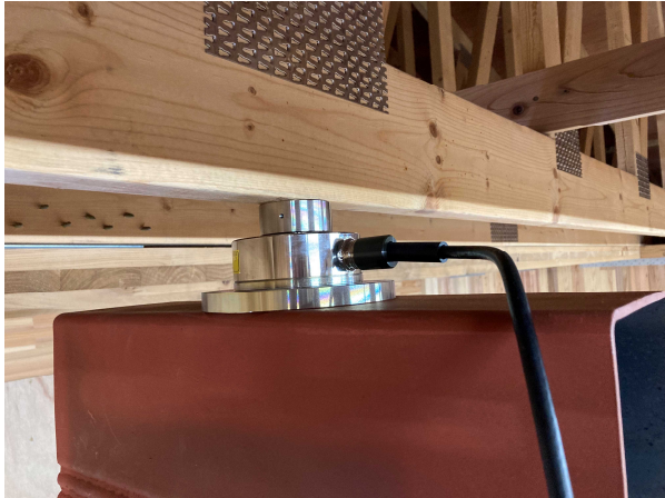
写真 1.3.3 再掲 荷重計の設置
