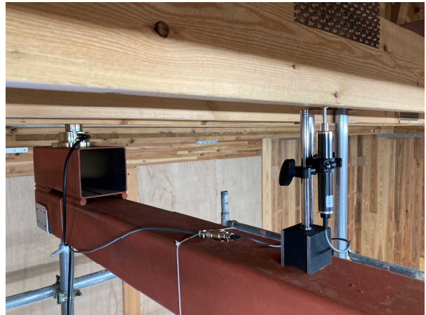
写真 1.3.2 計測機器の設置
